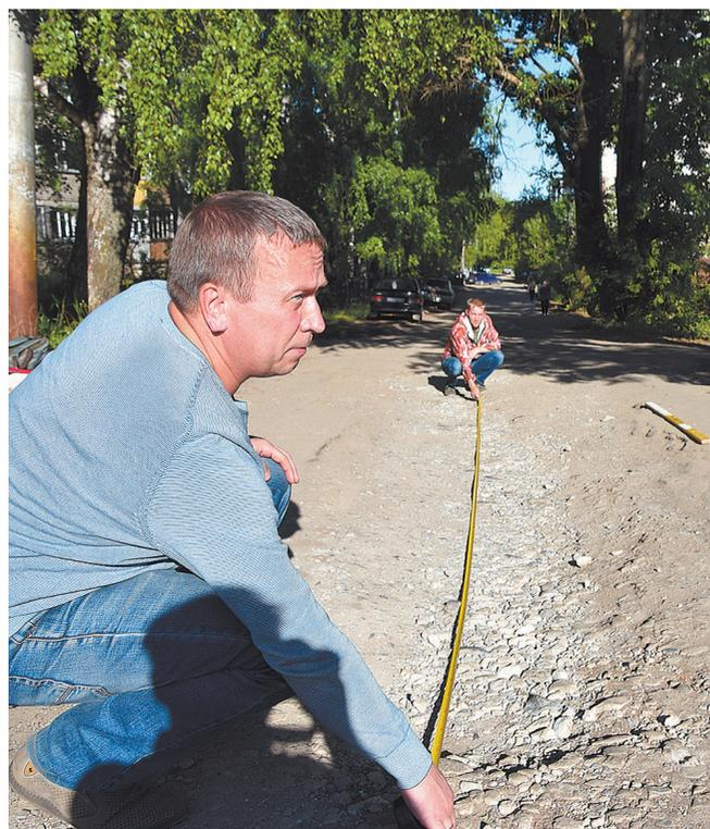
– Дорога в ужасном состоянии находится уже много лет. Выбоины и ямы на этом участке значительно превышают требования ГОСТа – более 60 см в ширину, более 15 см в длину и более 5 см в глубину. Для измерения
